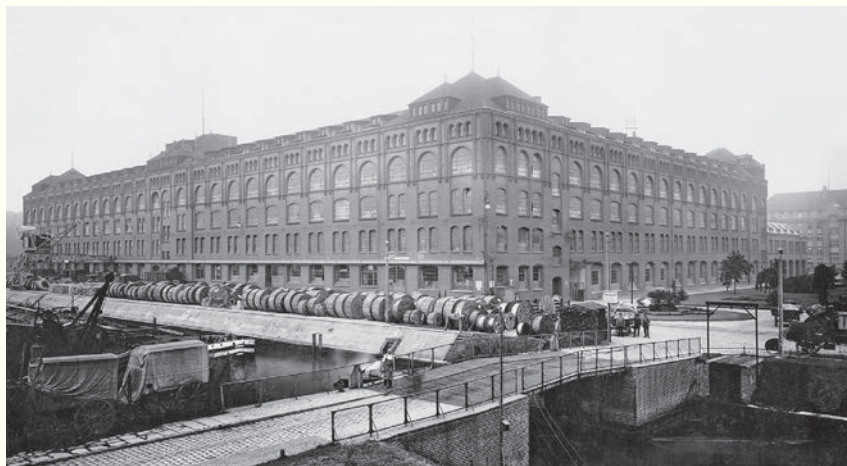
Кабельный завод в Вестэнде, первое предприятие будущего Сименсштадта. Около 1899 г.
