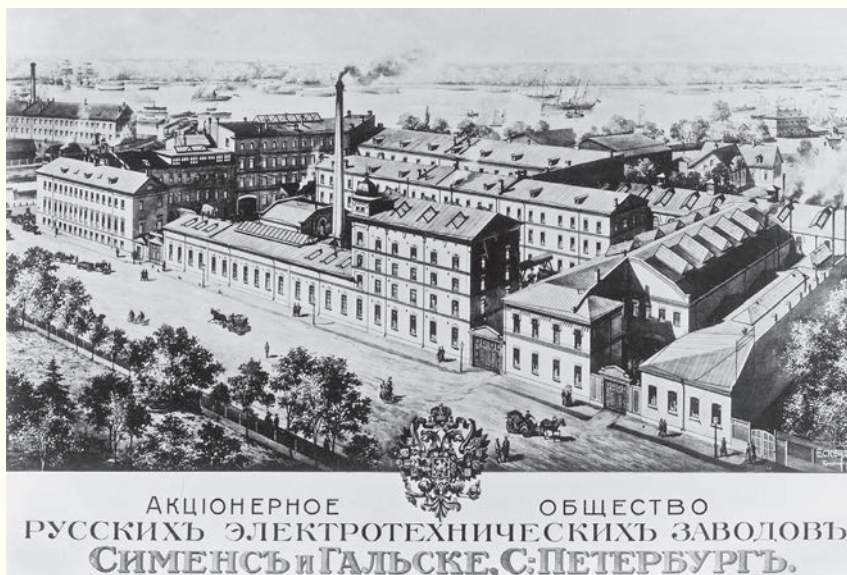
Завод по производству динамо-машин и электродвигателей «Сименс и Гальске» на Васильевском острове в Санкт-Петербурге
